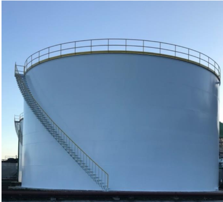
Figura 4. Tanque para agua de una capacidad de 700m 3
